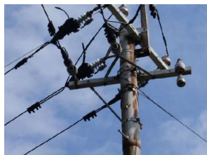
【活用例②：設備の劣化判定に活用】
